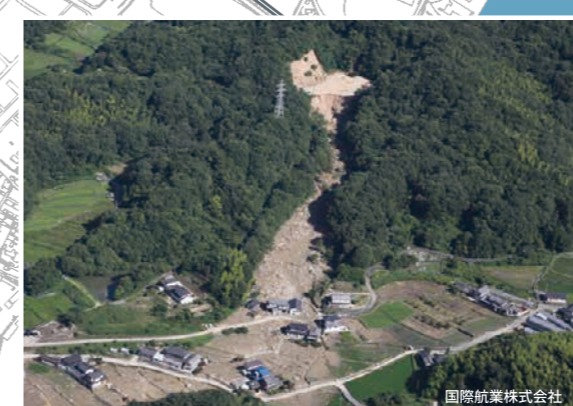
平成30年7月豪雨時のため池決壊後の様子(広島県福山市)
